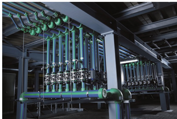
Vorgefertigter Verteiler aus aquatherm blue pipe für eine Industrieanwendung. Foto: aquatherm GmbH
